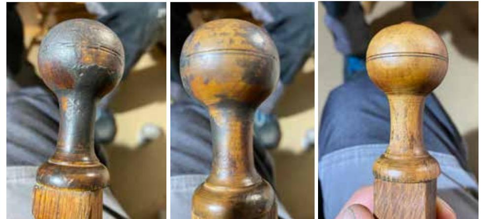
*Der Kopf eines Registerzugs: vor, während und nach der Reinigung*
