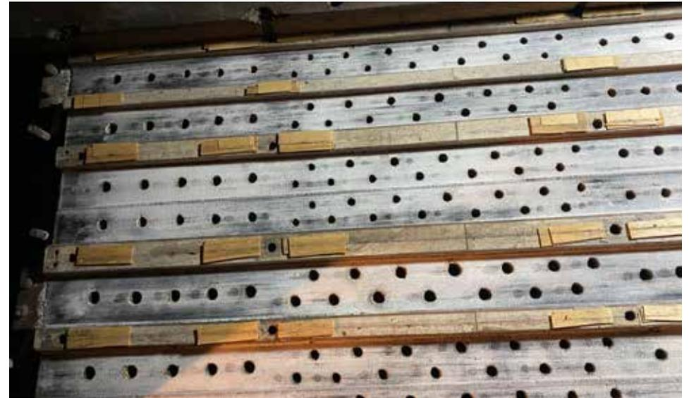
Dieselbe Windlade bei abgehobenen Pfeifenstöcken und Schleifen, Blick auf die originalen Lederbahnen
